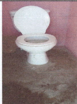
Foto 7: SUSTITUCION DE INODORO (INCLUYE INSTALACION Y MATERIALES)
