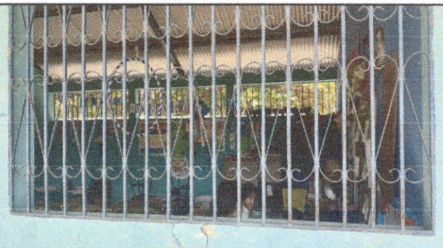
Foto 4: SUSTITUCION DE BALCONES DE METAL
