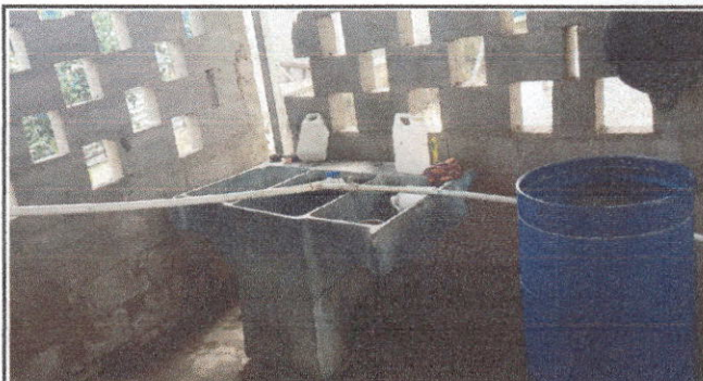
Foto 10: SUSTITUCION DE PILA DE CEMENTO, (TANQUE)
