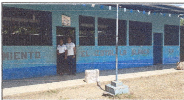
Foto 6: PINTURA EN MUROS EXTERIORES E INTERIORES
