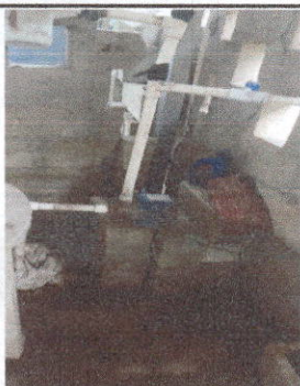
Foto 9: SUSTITUCION DE BOMBA DE AGUA
