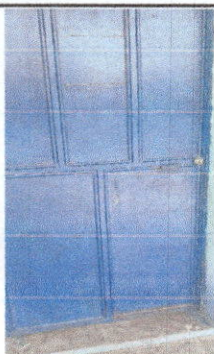
Foto 3: SUSTITUCION DE PUERTAS
