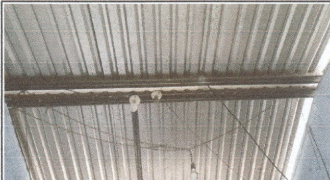
Foto 8: SUSTITUCION DE FOCOS AHORRADORES, Y PLAFONERAS
