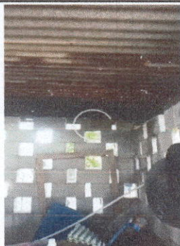
Foto1: Sustitución de lámina, por lámina troquelada aluzinc calibre 26. En cocina
